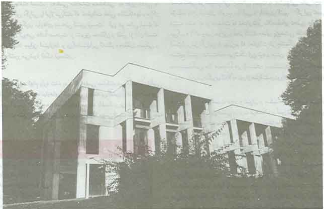
ساختمان مرکزی، مرکز تحقیقات فیزیک نظری و ریاضیات، نیاوران
